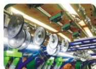
高速机安装 high speed machine installation
